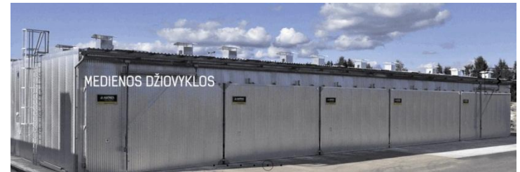
Šiuolaikinių medienos džiovinimo konteinerinių džiovyklų pavyzdys
